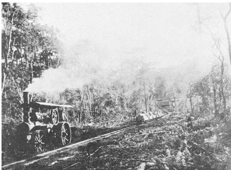
Transporte de madeira bruta através da utilização de ramal ferroviário, realizado pela empresa H. A. Hacker, no distrito de Carazinho, em 1918. Fonte: Relatório apresentado ao Conselho Municipal pelo intendente Coronel Pedro Lopes de Oliveira, em 1º de novembro de 1918. Passo Fundo: Oficinas d'A Federação, 1919, p. 10.
